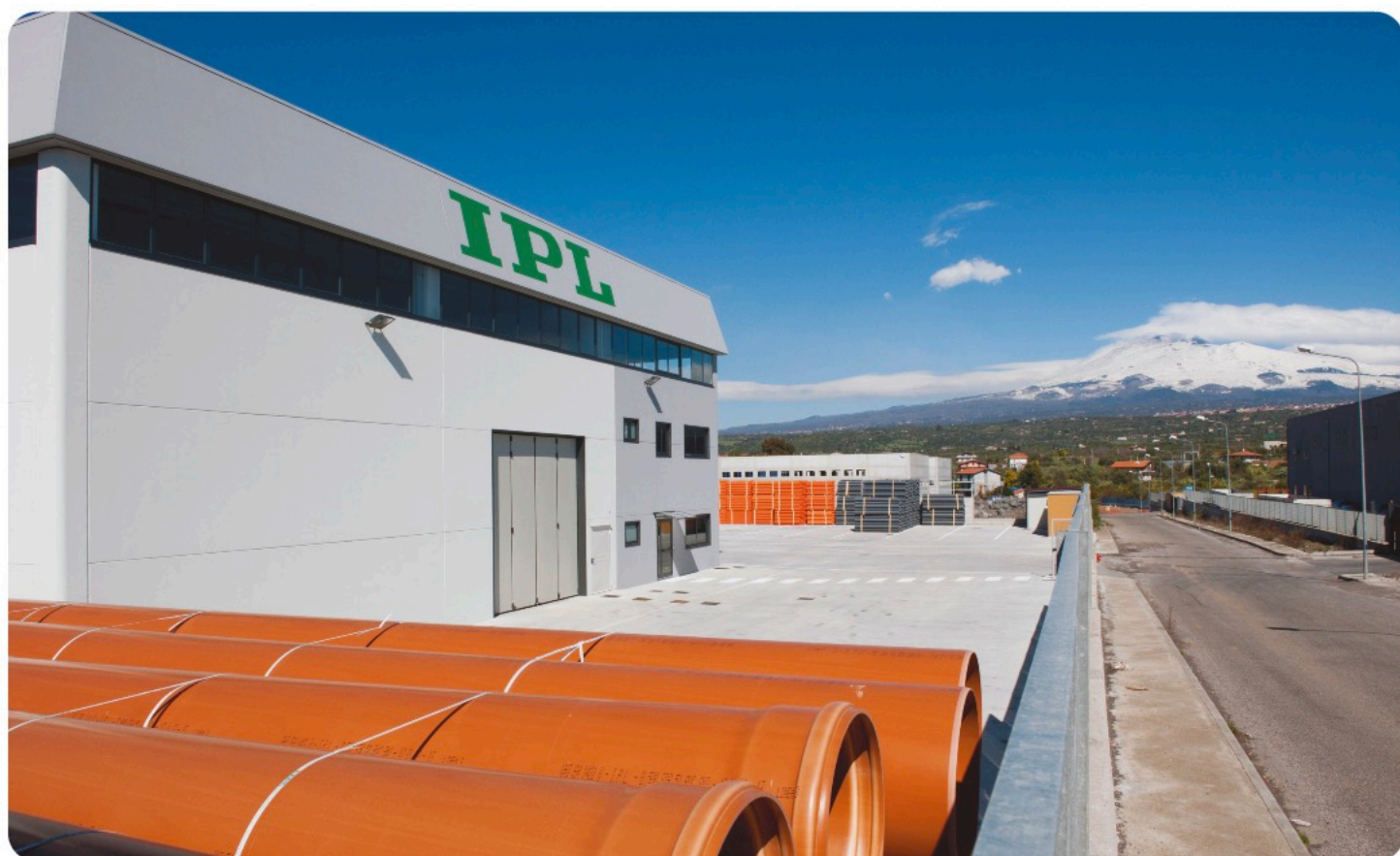
Sede legale e stabilimento di Valcorrente - Belpasso (CT) dal 2012
